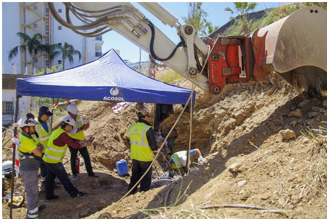
Los trabajos de reparación de la tubería. / M. H.
