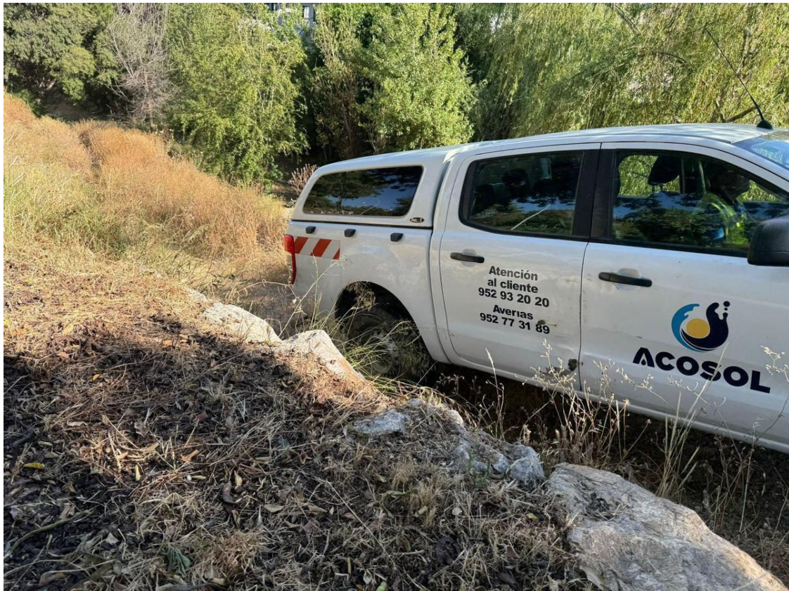
Acosol estima que podrá reparar la tubería de Benalmádena en dos o tres días. / L.O.
