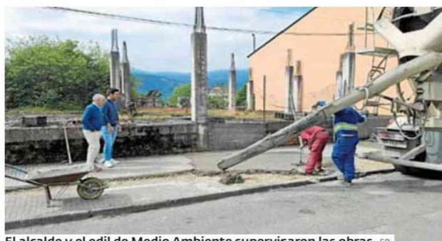
El alcalde y el edil de Medio Ambiente supervisaron las obras. EP
