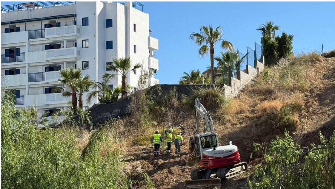
Operarios de Acosol trabajan en la reparación de la tubería rota en Benalmádena junto al hotel Los Patos. / L.O.
